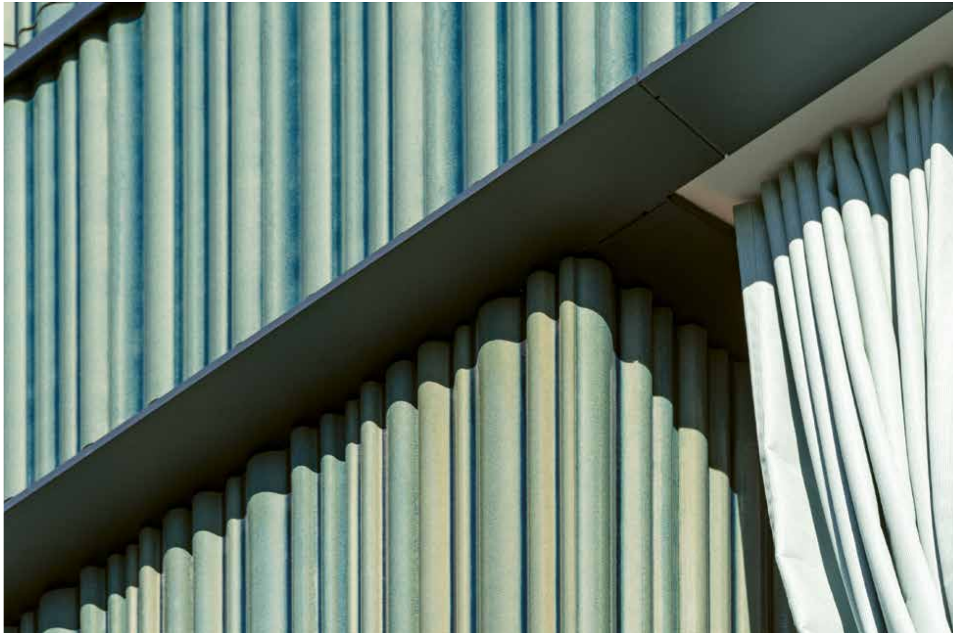
Fassadendetail vom Alterspflegeheim Humanitas in Riehen.
